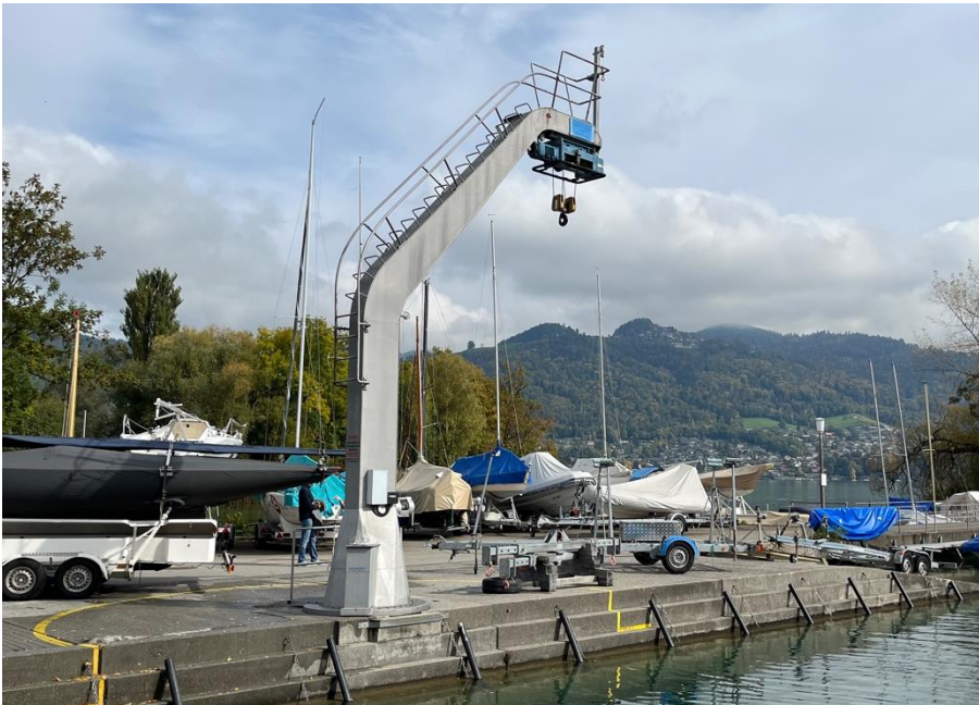
Abbildung 3, Parkposition des Krans
